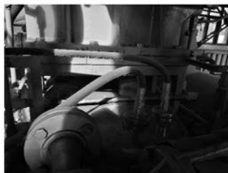
图 1 在油箱上安装滤油管
