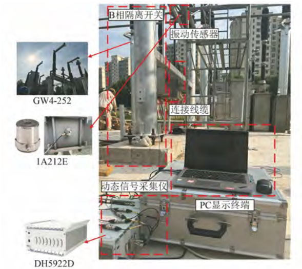
图 4 隔离开关振动试验平台 Fig. 4 Disconnector vibration experimental platform
