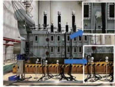
图 1 变压器拾音器部署图:右上为接触式拾音器,右下为非接触式拾音器
